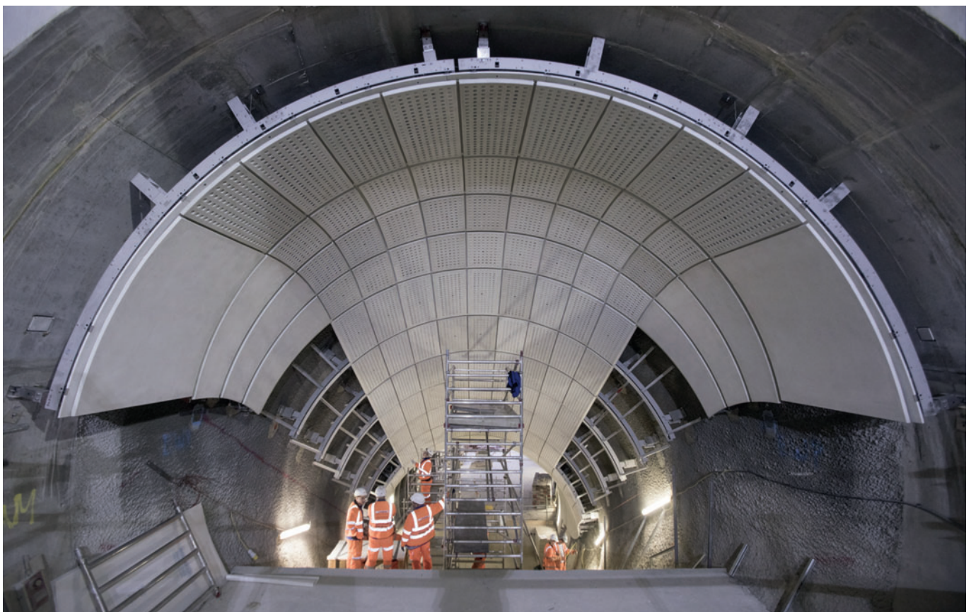
Die vorgehangenen Fassadenpaneele aus Glasfaserbeton werden im Druckspritzverfahren hergestellt.
